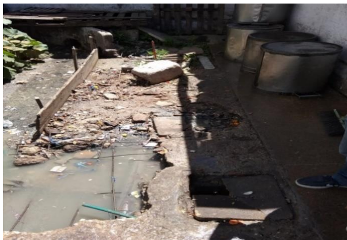
Foto 6 - Detalle del estado del desagüe y parte posterior de la cocina
